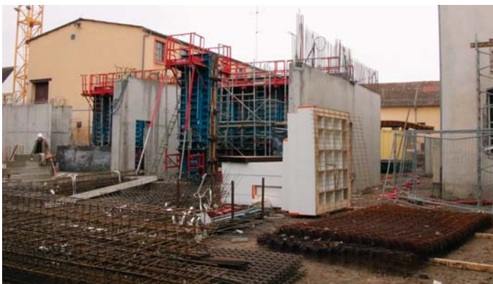
Emsig wird in Rixheim an der Ergänzung des städtischen Wahrzeichens, der Kommanderie, gebaut. Im Dezember begannen die Arbeiten für den multifunktionalen Anbau an die Gebäude aus den 30er Jahren des 18. Jahrhunderts. (Foto: W. Steinke)
