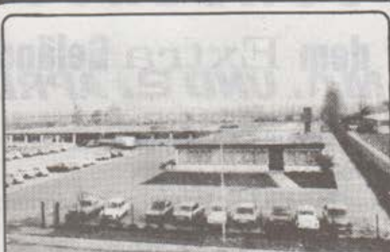
Gesamt Ansicht: Verwaltung, Zentrallager
