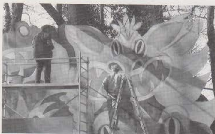
Malerarbeiten in schon schwindelnder Höhe.
