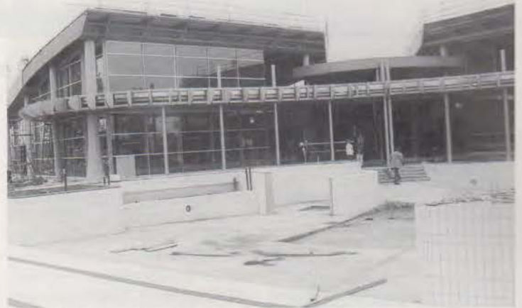
Die letzten Kacheln im Freibad sind mittlerweile auch befestigt, so dass der nächste Winter kommen kann. Dahinter befindet sich das architektonisch interessant gestaltete Hallenbad, eines der modernsten im Elsass.
