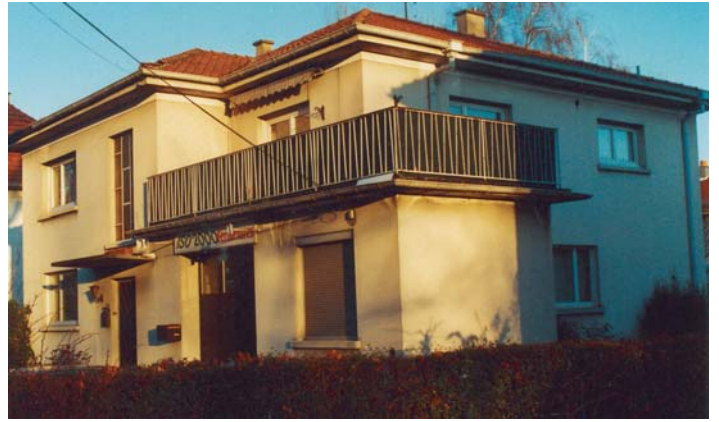
Zu klein war diese erste Dépendance der Firma Pöppelmann im Elsass, so dass ein Umzug nach Rixheim geplant wurde. Letztlich ein Glücksfall auch für die Geschichte der beiden Städte. (Foto: W. Steinke)
